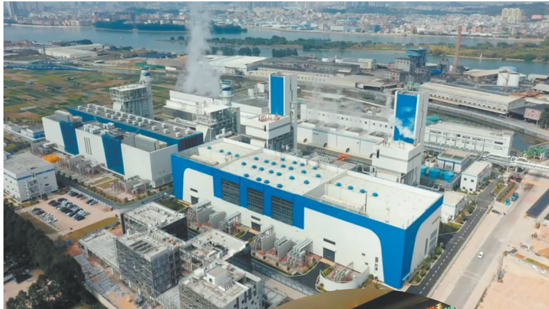
■东莞市粤湾新能源有限公司是广东省重点项目和东莞市重大建设项目
